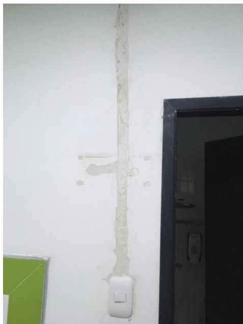
CONEXIÓN DE TUBERIA ELECTRICA
