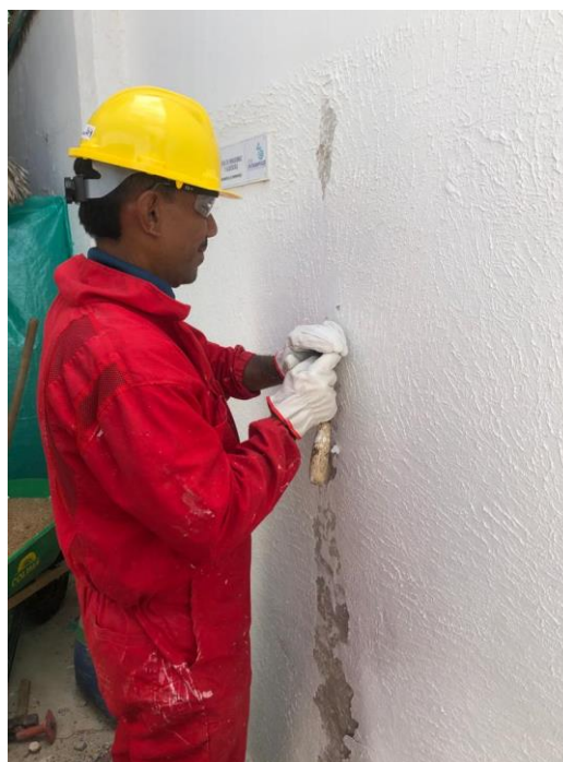
RESANE DE GRIETAS Y FISURAS EN MUROS
