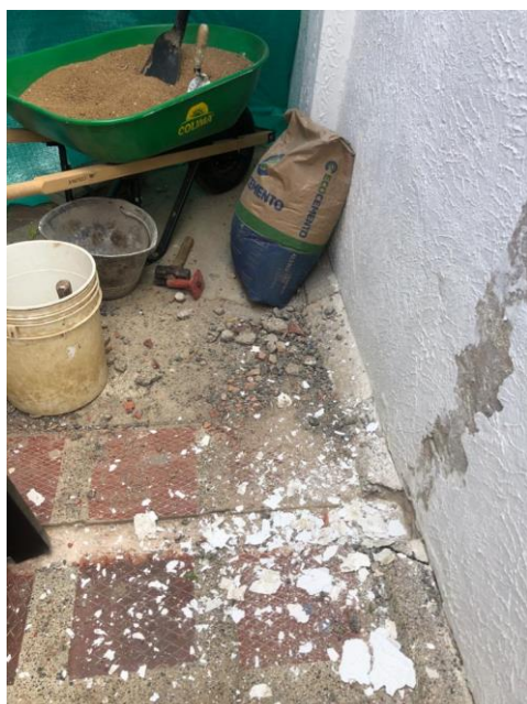
RESANE DE GRIETAS Y FISURAS EN
