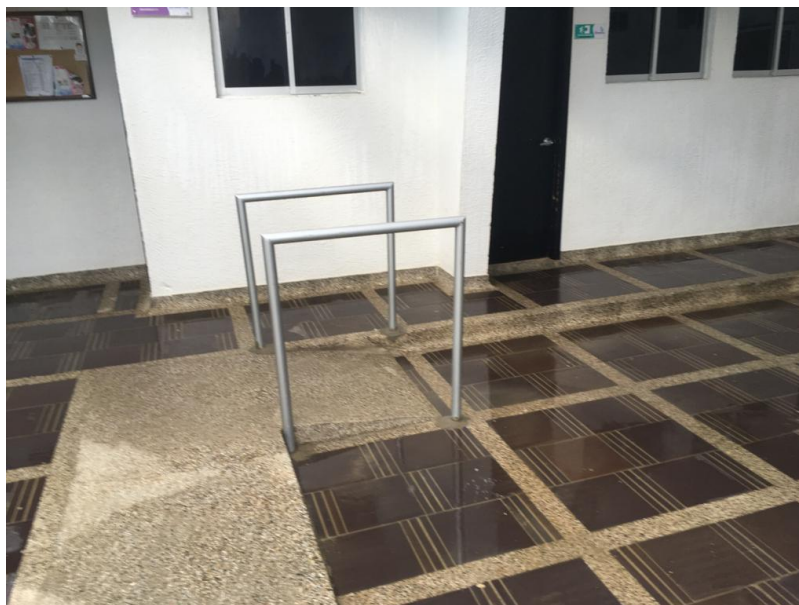
INSTALACION DE PASAMNAOS PARA
