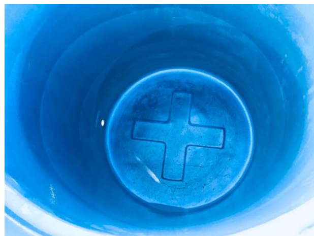
MANTENIMIENTO Y LAVADO DE TANQUES DE AGUA
