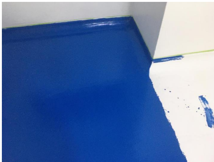
MANTENIMIENTO Y PINTURA DE PISO EN PINTURA
